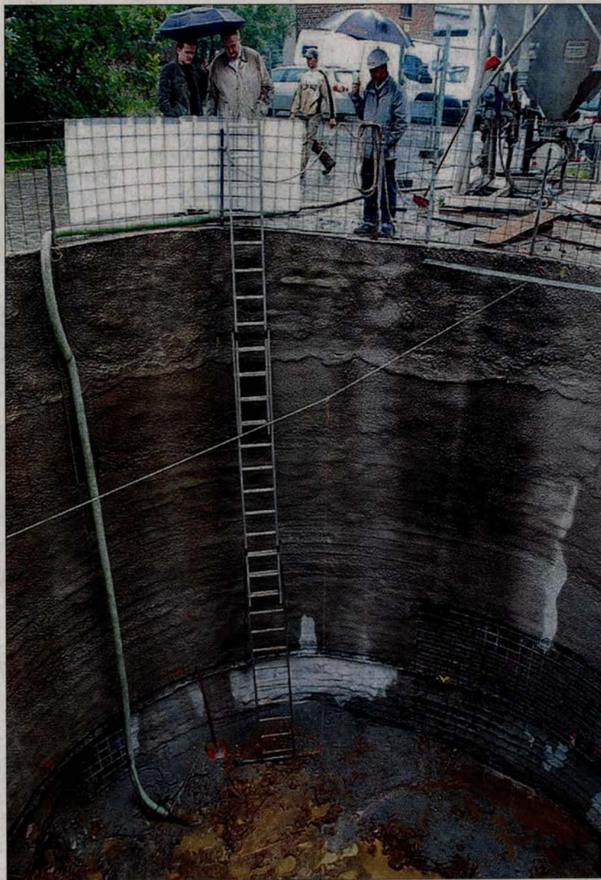
Von diesem über acht Meter tiefen Startschacht aus werden die neuen Kanäle in beide Richtungen durch das Erdreich getrieben. (WR-Bilder: Reitmajer)
