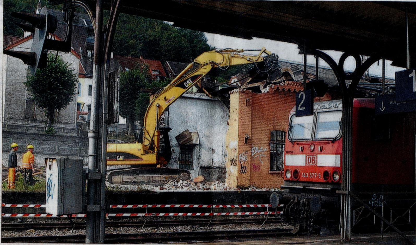
Während die Züge in den Hohenlimburger Bahnhof einlaufen, wird der Güterschuppen auf der anderen Seite der Gleise nun vollständig abgerissen. Die Bahn schafft so Platz für den Brückenbau, der den Bahnübergang an der Herrenstraße ersetzen wird. (WR-Bilder: Reitmajer)
