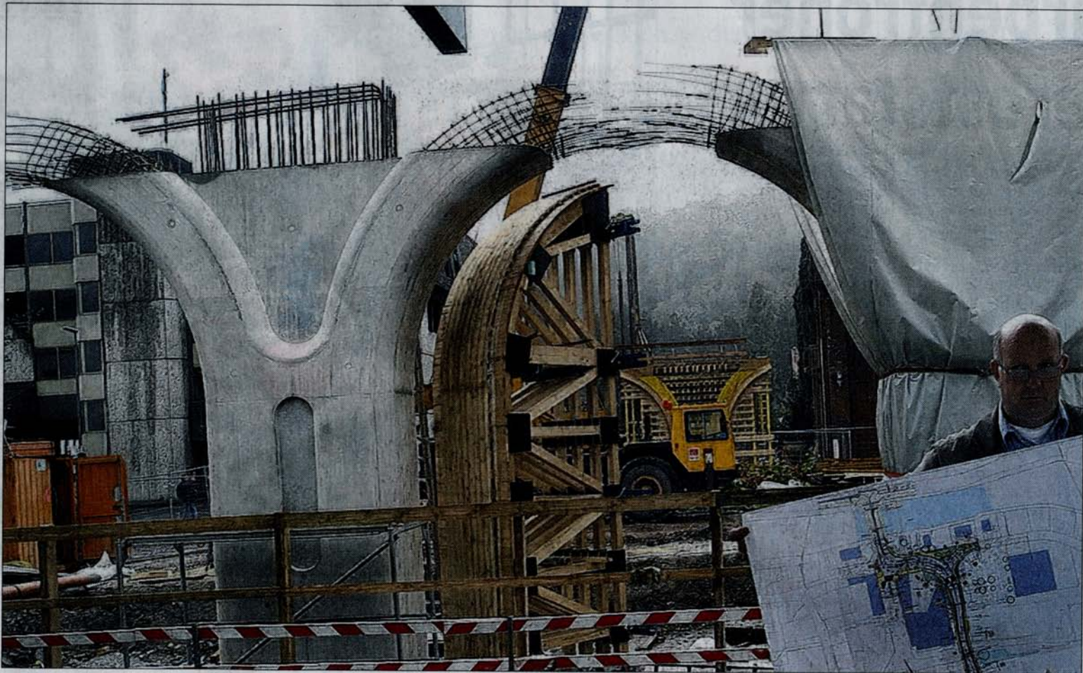
Werner Lehmkuhler, städtischer Bauleiter Brückenbau, hält den Ansichtsplan des Bauwerkes in den Händen. In seinem Rücken erhebt sich einer von fünf Brückenpfeilern, der bereits gegossen wurde. Die geschwungene Herzform soll die Pfeiler leicht und nicht wuchtig erscheinen lassen.
