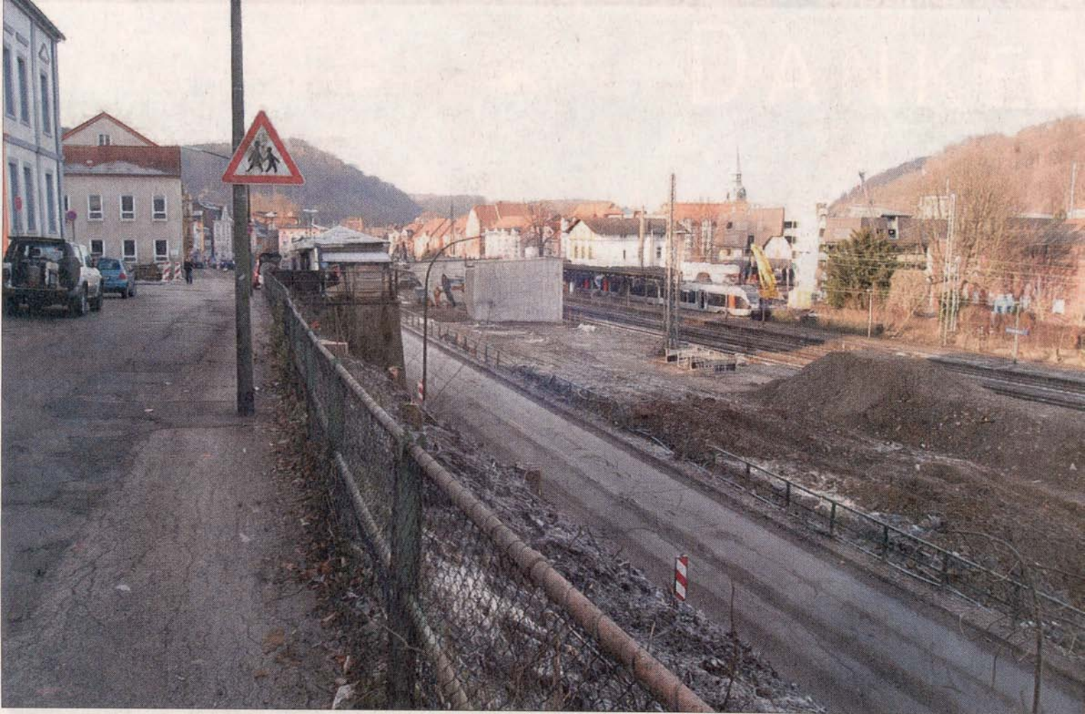
Die Stützpfiler für den Brückenneubau stehen schon. Ansonsten bieten Obere und Untere Isenbergstraße in diesen Tagen und Wochen fast den Anblick einer Mondlandschaft. Ab kommenden Montag finden hier weitere Tiefbauarbeiten statt. (WR-Bild: Ulrich Leifert)
