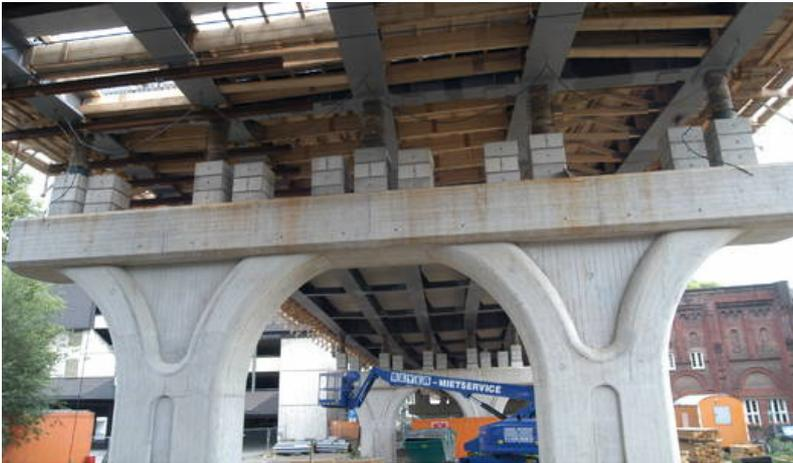
Ende August wird die Brücke von den provisorischen Stützen genommen und auf ihre Lager gesetzt. Dann wird das Bauwerk etwa 1,80 Meter tiefer liegen, als das jetzt während der Montagearbeiten der Fall ist. (WR-Bilder: Reitmajer)
